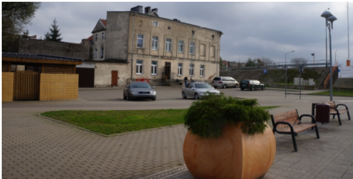
Zdjęcie 42. Obiekt mieszkalny o niskiej estetyce w bezpośrednim sąsiedztwie Nabrzeża
